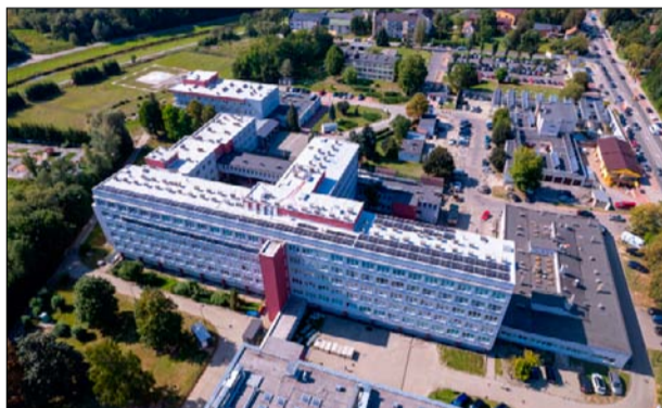
Szpital Powiatowy w Limanowej po termomodernizacji
